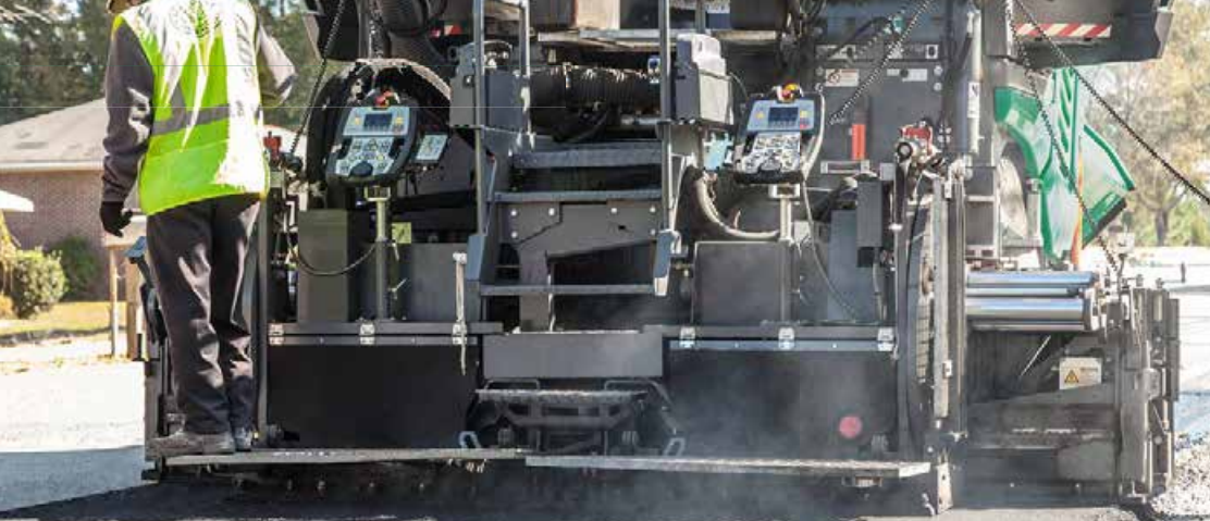
Гусеничный асфальтоукладчик Vögele укладывает асфальтобетон
